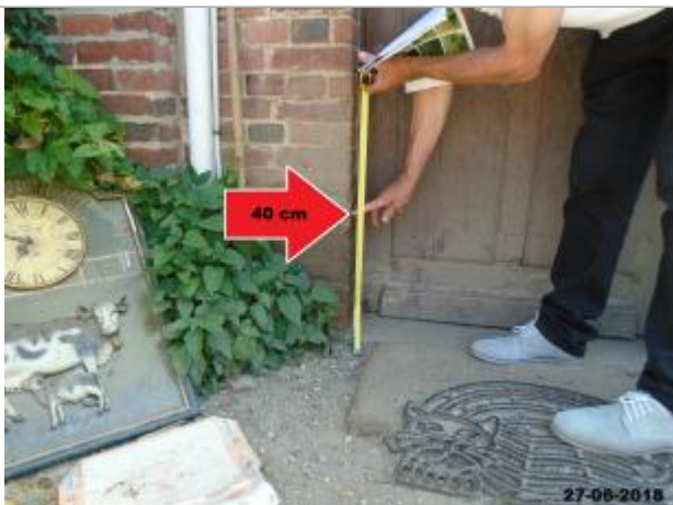
Trace d'humidité sur la façade ouest de l'habitation (Façade principale vue de la RD111A)
