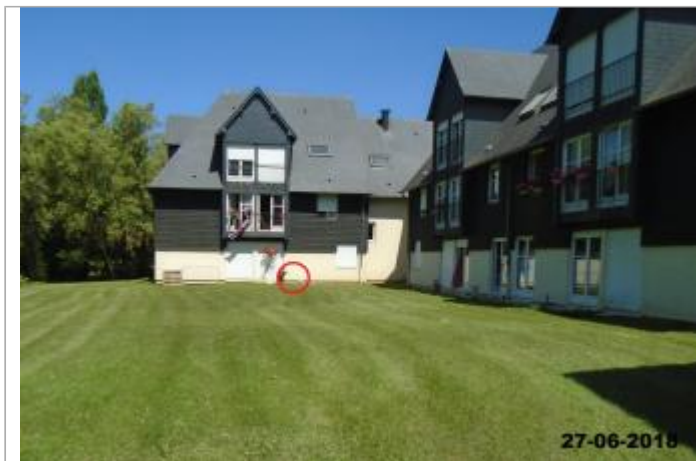
Photo du site vers repère
