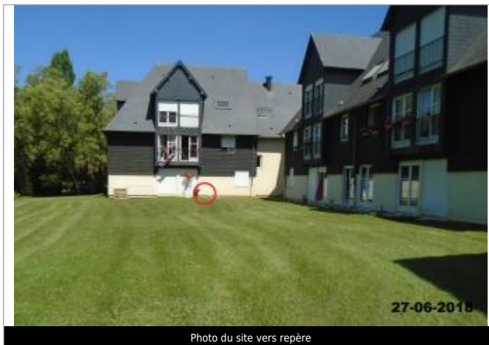
Photo du site vers repère
