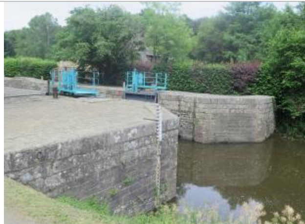
Aval de l'écluse de la Molière à Saint-Senoux
