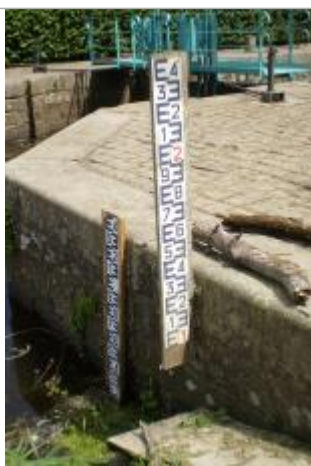
Echelle limnimétrique amont de l'écluse de la Molière à Saint-Senoux
