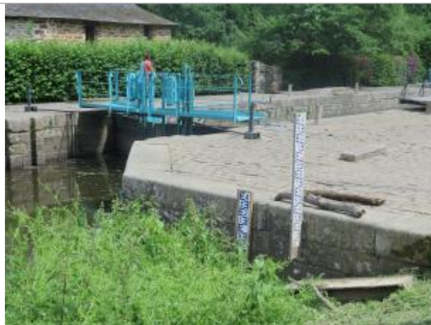
Amont de l'écluse de la Molière à Saint-Senoux
