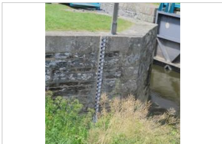
Echelle limnimétrique n°1 sur le bajoyer amont de l'écluse de Gailieu à Guichen
