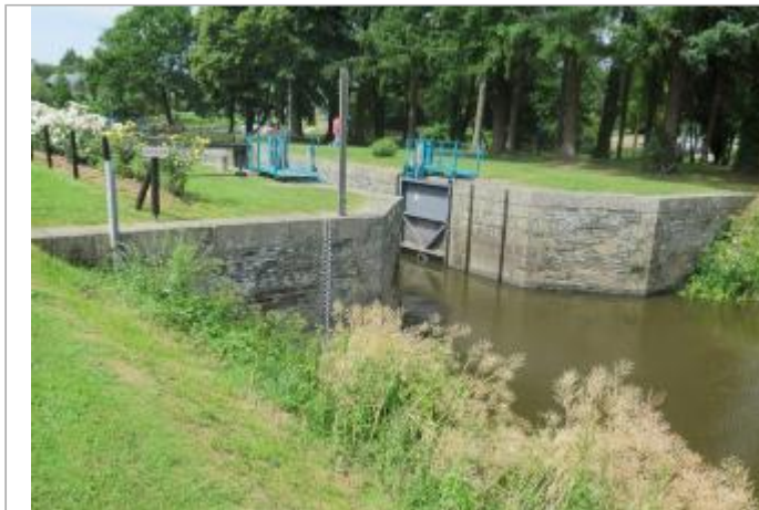
Aval de l'écluse de Gailieu à Guichen
