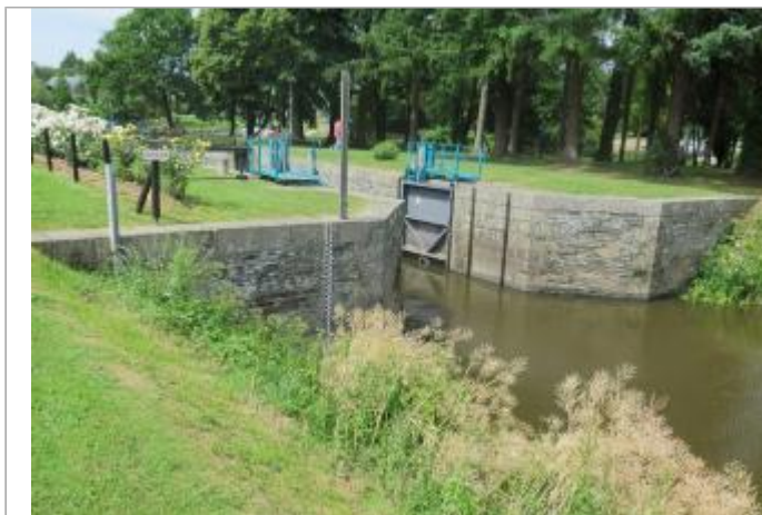
Aval de l'écluse de Gailieu à Guichen
