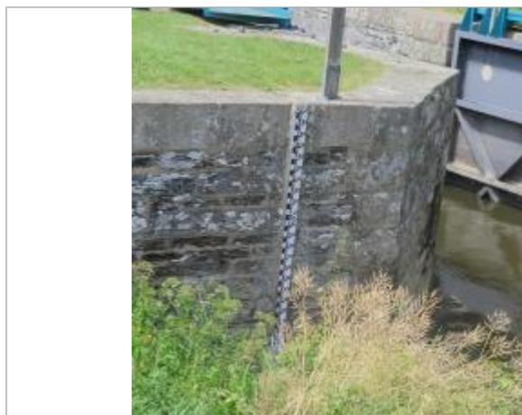
Echelle limnimétrique n°1 sur le bajoyer amont de l'écluse de Gailieu à Guichen
