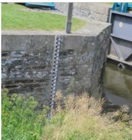
Echelle limnimétrique n°1 sur le bajoyer amont de l'écluse de Gailieu à Guichen
