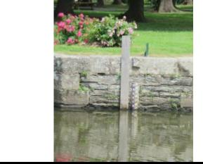
Echelle limnimétrique à l'amont de l'écluse de Gailieu à Guichen
