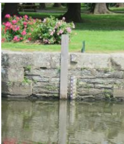
Echelle limnimétrique à l'amont de l'écluse de Gailieu à Guichen
