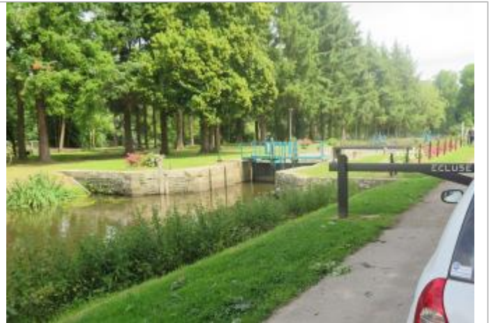
Amont de l'écluse de Gailieu à Guichen
