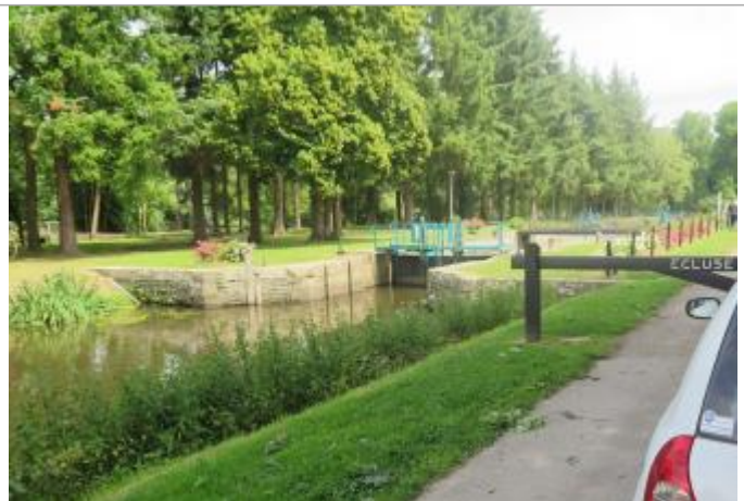
Amont de l'écluse de Gailieu à Guichen
