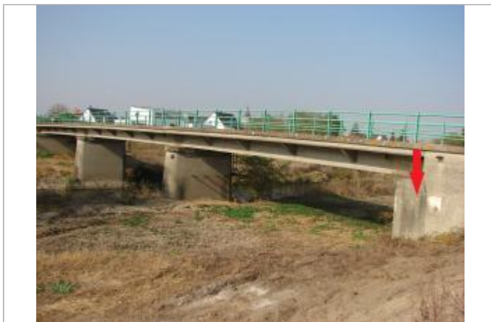
Vue général du site
