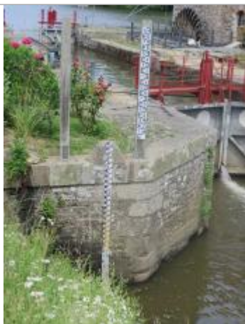
Echelle limnimétrique à l'aval de l'écluse de La Bouexière à Guichen
