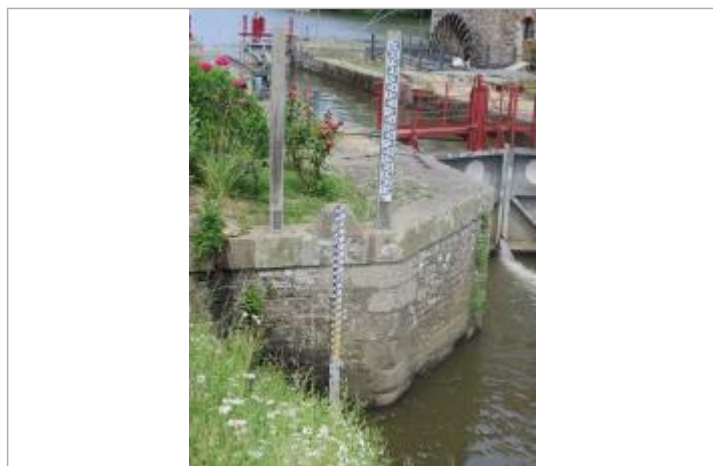
Echelle limnimétrique à l'aval de l'écluse de La Bouexière à Guichen
