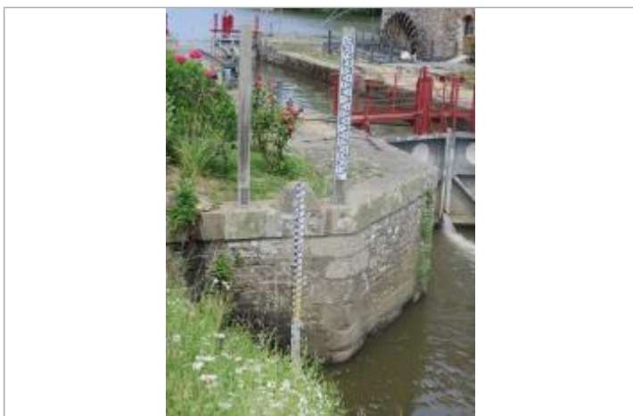
Echelle limnimétrique à l'aval de l'écluse de La Bouexière à Guichen
