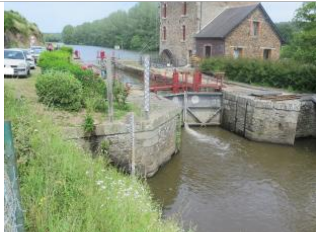
Aval de l'écluse de La Bouexière à Guichen
