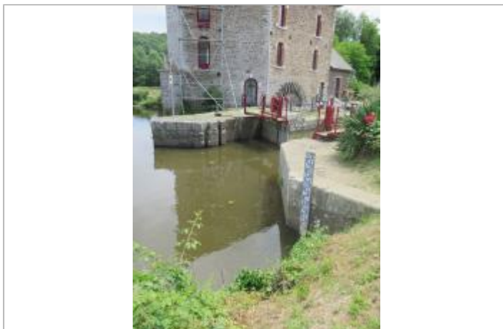
Amont de l'écluse de La Bouexière à Guichen
