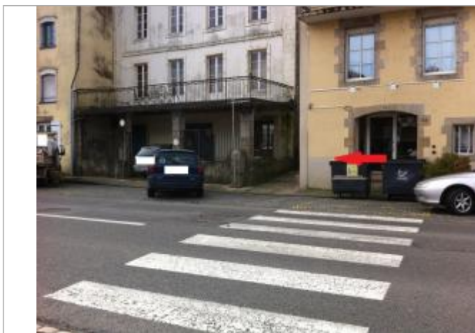
Mur du porche d'entrée du 8 quai Brizeux.
