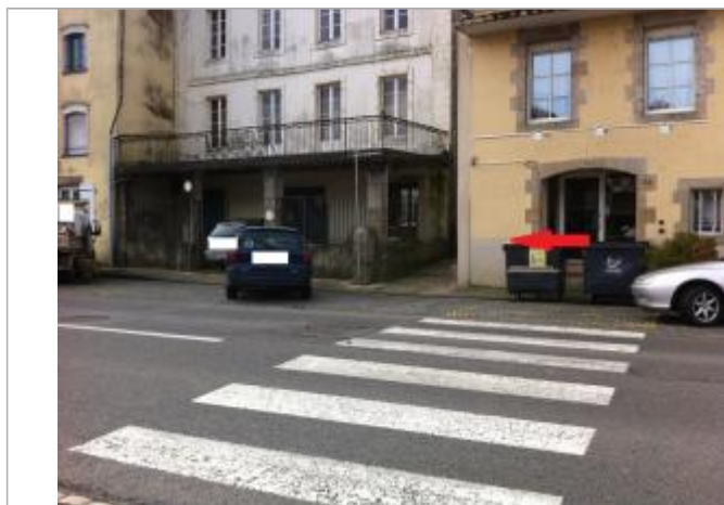
Mur du porche d'entrée du 8 quai Brizeux.
