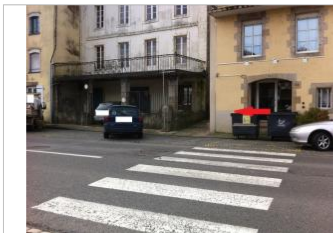
Mur du porche d'entrée du 8 quai Brizeux.
