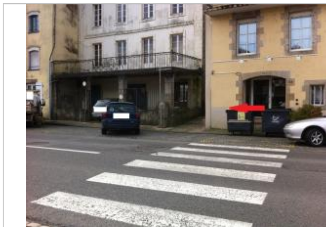
Mur du porche d'entrée du 8 quai Brizeux.
