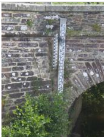
Echelle limnimétrique à l'amont du pont de Pont-Réan à Bruz
