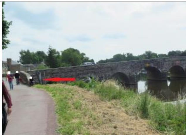
Amont du pont de la RD 577 à Pont-Réan coté Bruz, rive gauche
