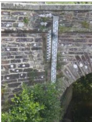
Echelle limnimétrique à l'amont du pont de Pont-Réan à Bruz
