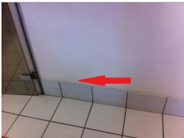
Plancher au niveau de la plinthe
