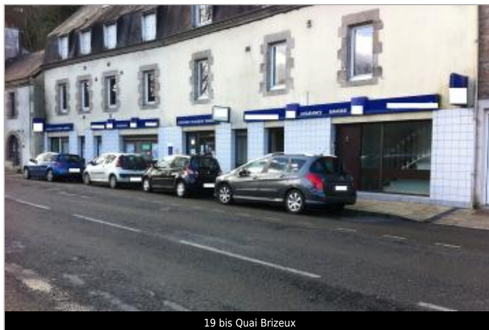
19 bis Quai Brizeux
