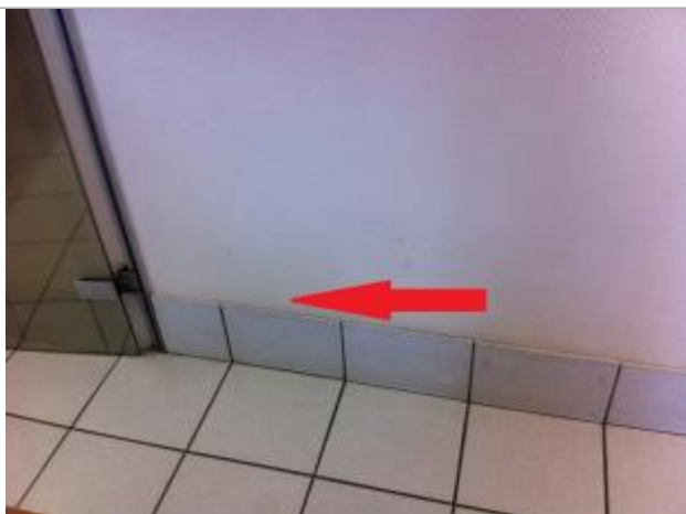
Plancher au niveau de la plinthe
