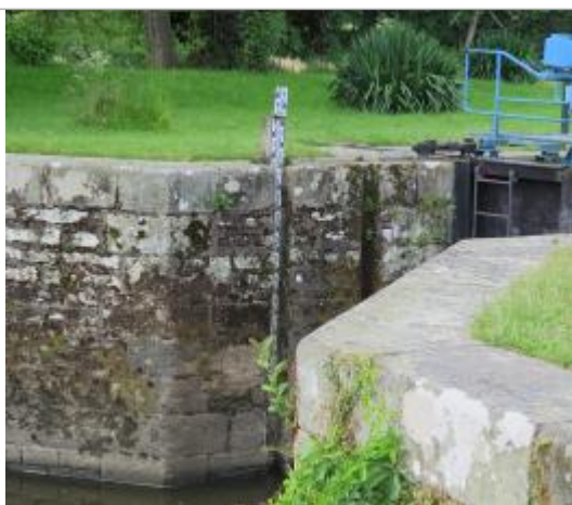
Echelle limnimétrique à l'aval de l'écluse de Pont-Réan à Bruz
