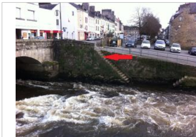
Marches d'escalier au niveau du quai Surcouf
