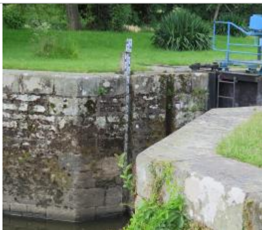
Echelle limnimétrique à l'aval de l'écluse de Pont-Réan à Bruz
