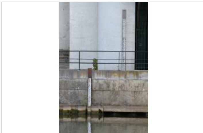
Echelle sous le pont côté Auvers
