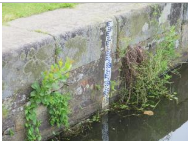
Echelle limnimétrique n°1 à l'amont de l'écluse de Pont-Réan à Bruz
