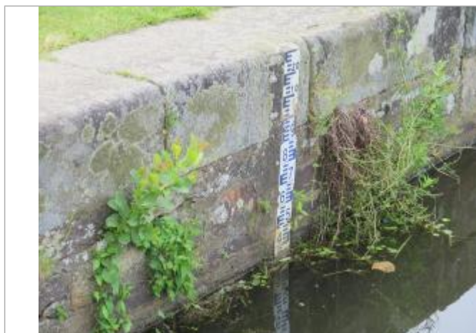
Echelle limnimétrique n°1 à l'amont de l'écluse de Pont-Réan à Bruz
