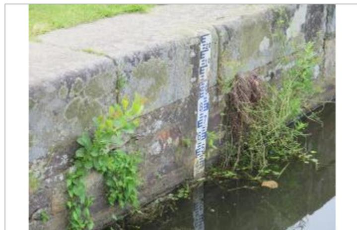
Echelle limnimétrique n°1 à l'amont de l'écluse de Pont-Réan à Bruz
