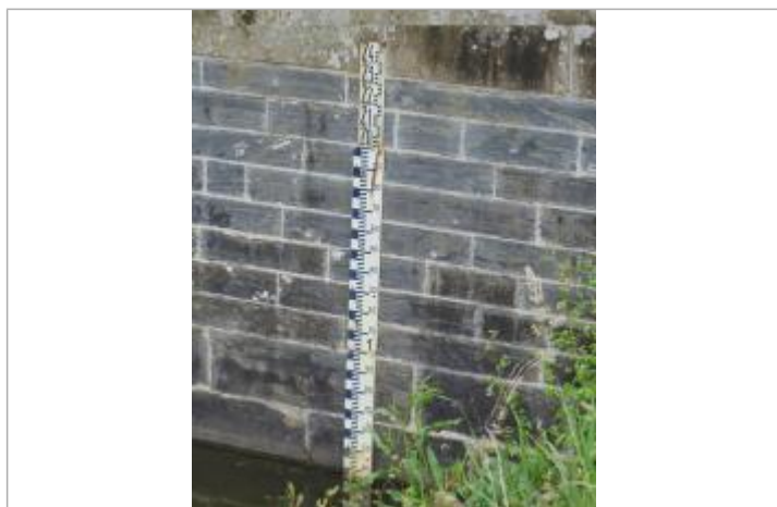
Echelle limnimétrique n°1 à l'aval de l'écluse de Mons à Bruz
