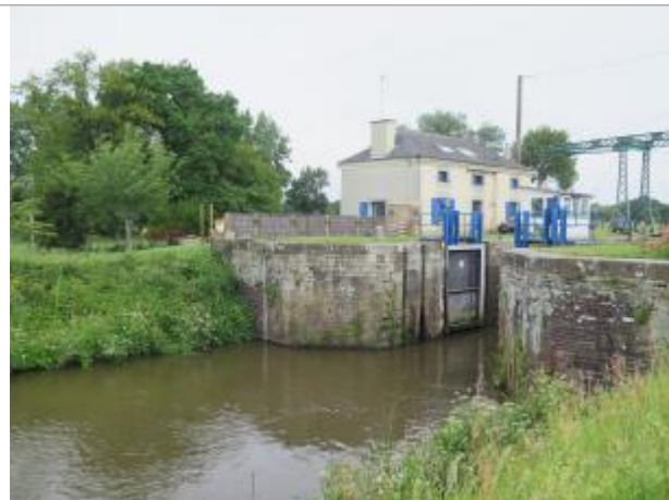
Vue générale de l'aval de l'écluse de Cicé à Bruz
