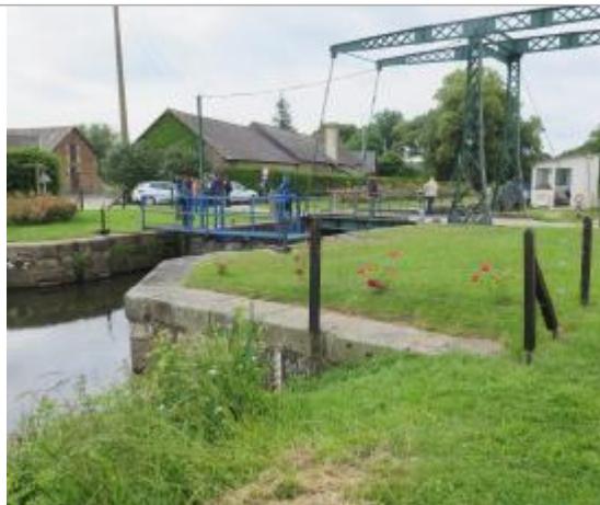
Vue générale de l'amont de l'écluse de Cicé à Bruz
