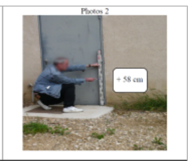
Trace du maximum de la crue sur le crépis du côté de la maison au 11 Rue Jules Vernes
