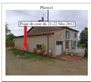
Trace du maximum de la crue sur le crépis du côté de la maison au 11 Rue Jules Vernes
