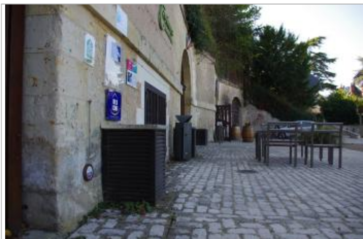
Repère de crue, vue de côté (source : Maison de la Loire 37)
