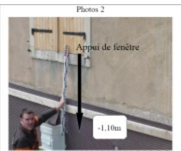
Trace du maximum de la crue sur le sous bassement de la maison du 32 rte de Bouxieres
