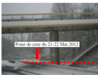
Trace du maximum de la crue sur la pile du pont de la VEBE
