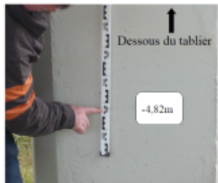
Trace du maximum de la crue sur la pile du pont de la VEBE
