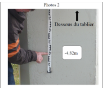
Trace du maximum de la crue sur la pile du pont de la VEBE
