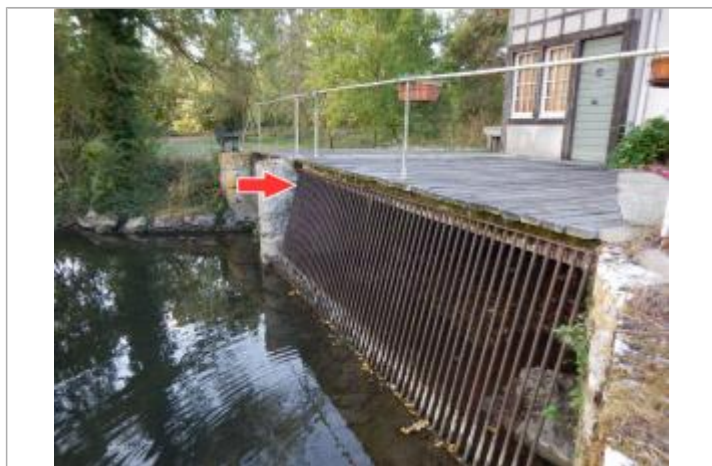
Repère de la crue de juin 2016 (source : SPC LCI)
