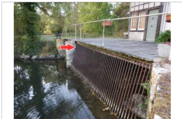
Repère de la crue de juin 2016 (source : SPC LCI)
