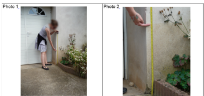
trace du maximum de la crue sur la façade à côté de la porte d'entrée du 2 rte de Serre
