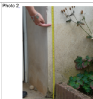
trace du maximum de la crue sur la façade à côté de la porte d'entrée du 2 rte de Serre
