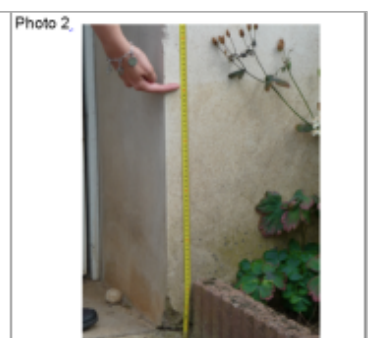
trace du maximum de la crue sur la façade à côté de la porte d'entrée du 2 rte de Serre
