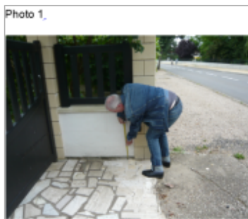
Trace du maximum de la crue sur le mur du portail
