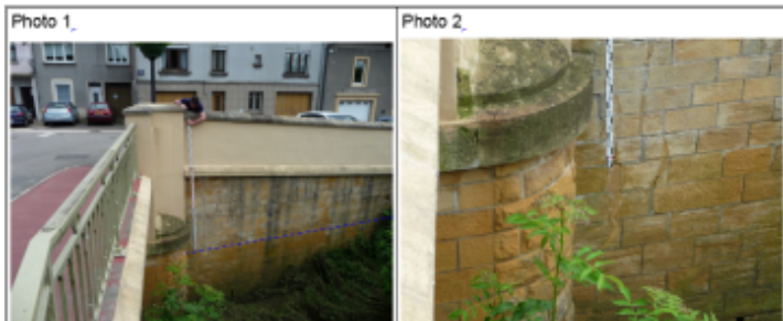
Trace du maximum de la crue sur le mur de soutènement en amont rive droite du pont de la RD130
