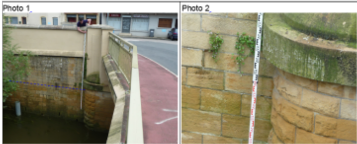
Trace du maximum de la crue sur le mur de soutènement en aval rive droite du pont de la RD 130
