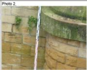
Trace du maximum de la crue sur le mur de soutènement en aval rive droite du pont de la RD 130
