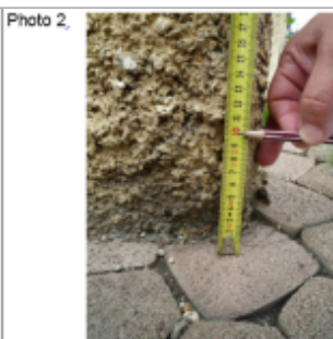
Trace du maximum de la crue sur la façade au coin de l'arue au 6 rue du Lavoir
