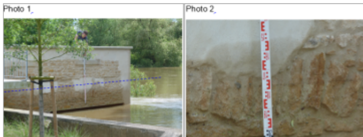
Trace du maximum de la crue sur le mur de soutènement
