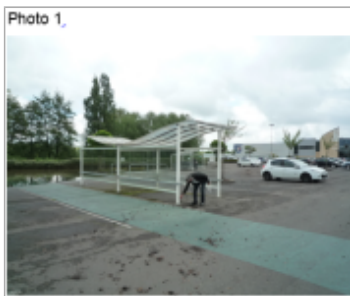
Trace du maximum de la crue sur un poteau de l'abris à caddy du parking du Leclerc
