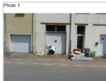
Trace du maximum de la crue sur la façade et la porte de garage du 11 rue de la filature
