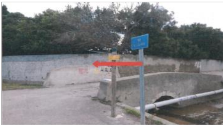
Ouvrage au dessus du ruisseau
