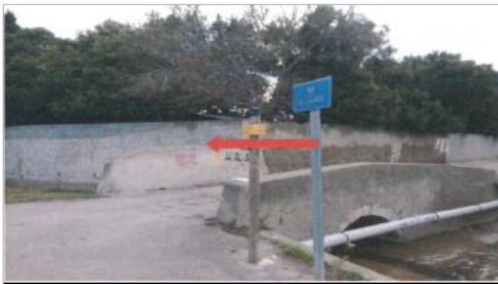
Ouvrage au dessus du ruisseau
