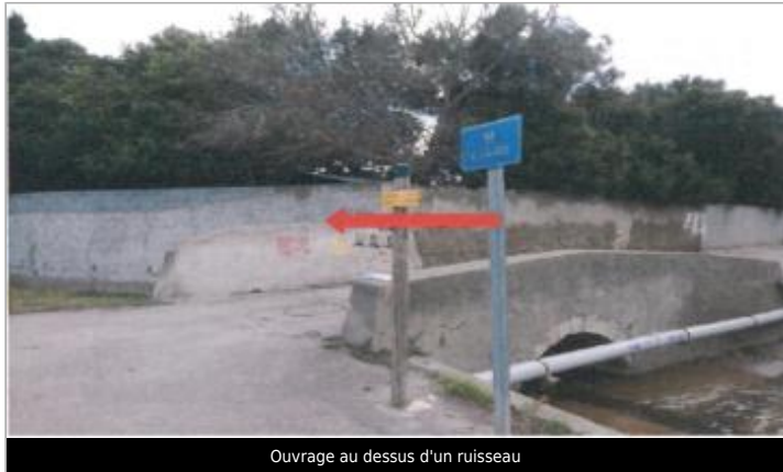
Ouvrage au dessus d'un ruisseau
